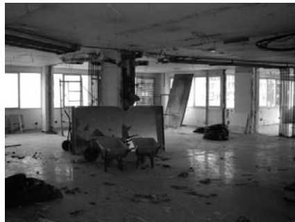
Estat de les obres a la planta principal
