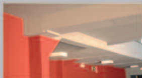
Protecció contra el foc d'estructures metàl·liques i de fusta amb panells rígids
