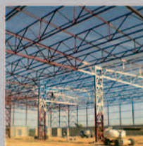
Protecció contra el foc d'estructures metàl·liques amb pintura intumescent
